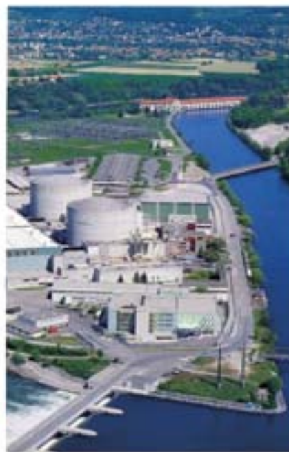
図3 操業から42年が経過したベツナウ発電所と原子力熱利用地域の一部
