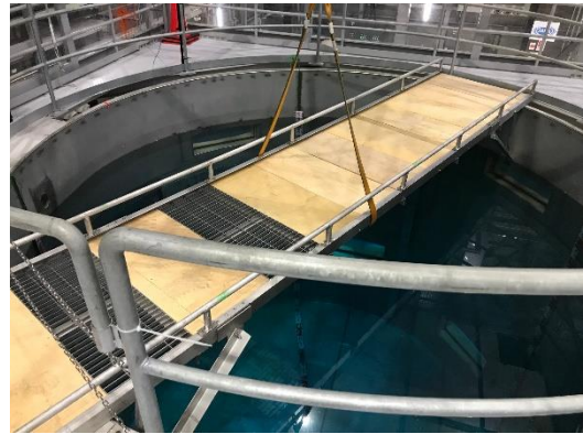
図 3.1-26 大型水槽上部の橋
