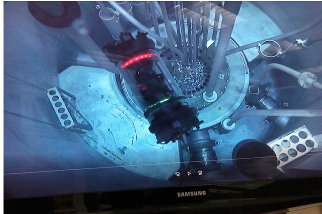
図 3.2.2-9 TRIGA Mark II 炉冷却用プール中の ROV
