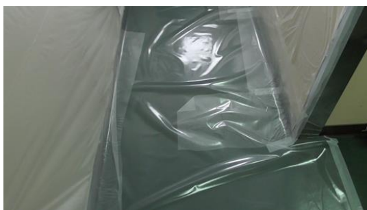
図 3-8 出入口からの床部分の養生
