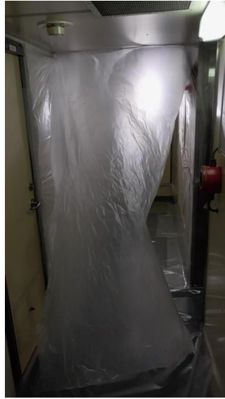
図 3-9 天井からたらしした養生シート
