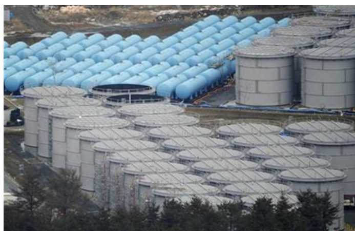
図 1-1 福島第一原子力発電所内の汚染水貯蔵タンク
